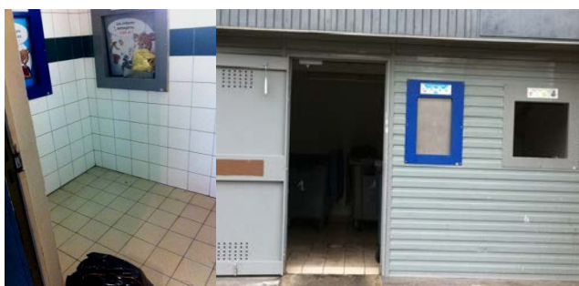
Deux dispositifs de trappes dans le quartier des Marnaudes, L'un en intérieur (fig. gauche), l'autre en extérieur (fig. droite)
